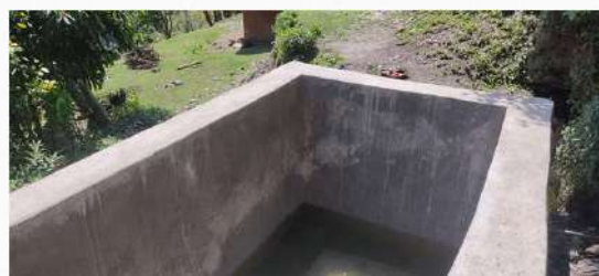
खलगाडा सिचाई पोखरी निर्माण योजना मल्ला तलापारा सिचाई पोखरी निर्माण योजना
