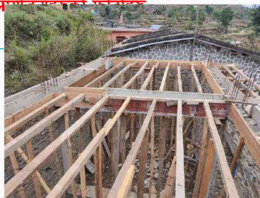
छुपाली स्वास्थ्य चौकी भवन निर्माण योजना
