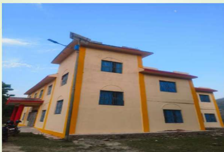
के.आई.सिंह-१, डुम्राकोटमा संग्रहालयको संचालनार्थ निर्माण गरिएको भवन
