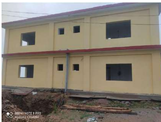
वडा नं. २ को वडा कार्यालय भवन निर्माण
