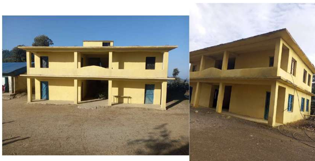
मेलघट्टी आ. बि अधुरो भवन निर्माण बडिकेदार गाउँपालिका वडा नं.५, अत्तरकाडा, डोटी
