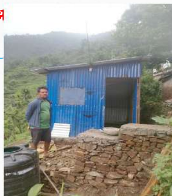
अटिजम बिरामी बिराज साउदको घर निर्माण योजना
